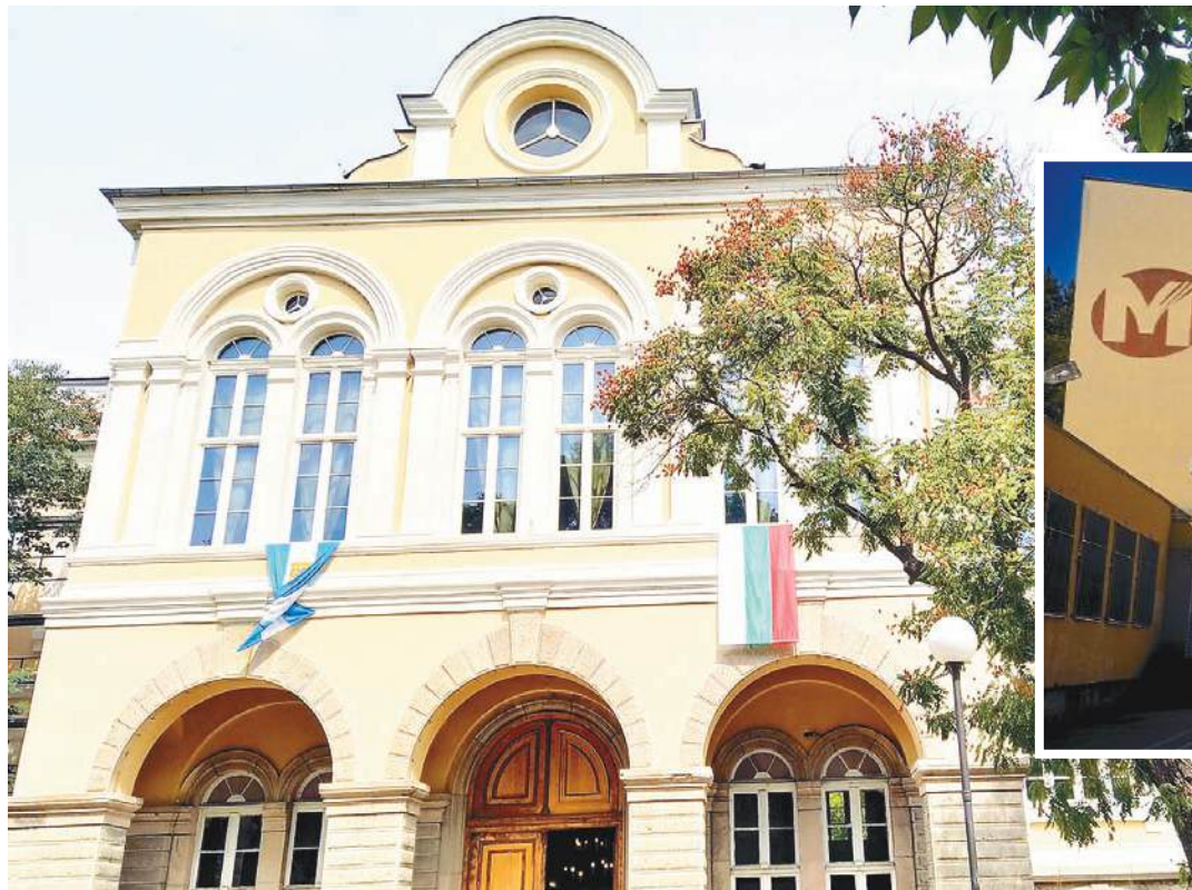
Фасадата на Хуманитарната гимназия се реновира. В сградата съжителства от години и ОУ „Княз Александър Първи“; за което ще се строи отделен корпус.
